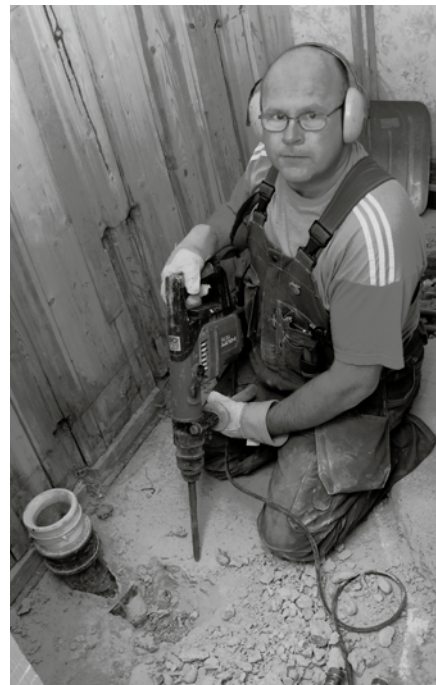
Här ska det bli ett alldeles nytt badrum i Börstorp, helkaklat och välutrustat. Urban Larsson har haft ett tufft jobb att få bort det gamla cementgolvet för att lägga nya rör.
