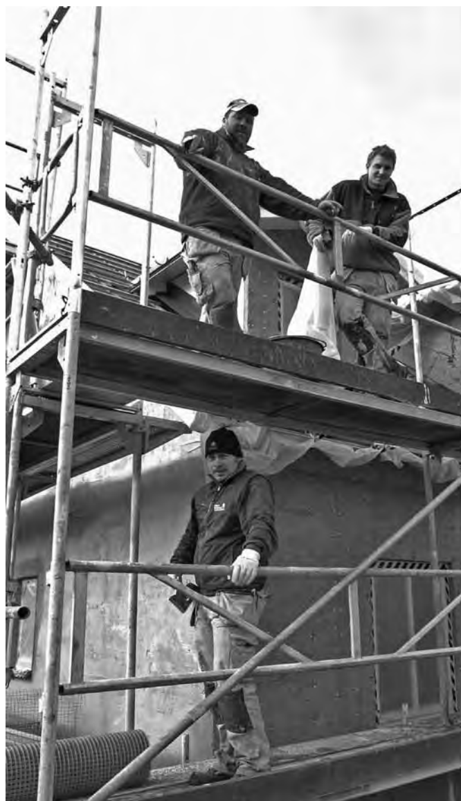
Peter Fridell, Martin Johansson (på övre planet) och Marcus Engström är tre av byggnadsarbetarna som varit med om att bygga villorna vid Nedre Bruket.
