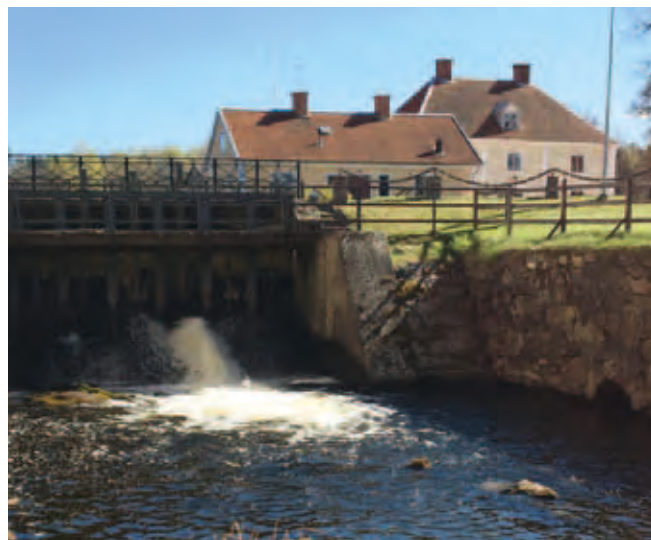
Vid bron mitt inne i Breven's Bruk skall en av fisktrapporna byggas.
