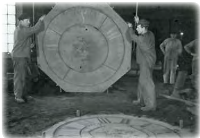
Herman Broms och Martin Pettersson vid den väldiga gjutform som ska skapa en urtavla, förmodligen till ett kyrktorn.
