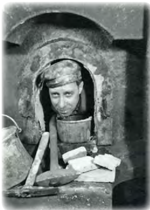
Erik Nilsson, ugnsskötare, murar kupolugnen inför gjutning.
