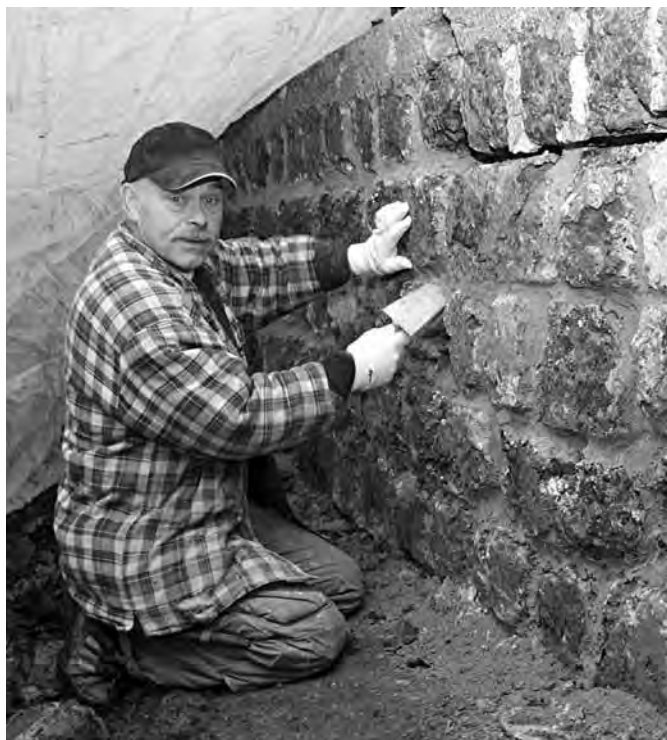
Murare Bonny Fallén har i ur och skur jobbat under hösten för att återskapa den gamla lastkajen i Brevens Bruk.
