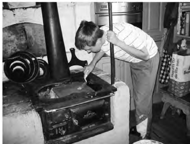
Gustav Wändell lägger sista handen vid ugnslerputsningen.
