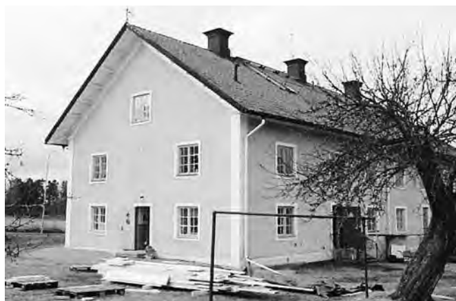
Flottbo – Övre Stenhuset – drabbades av hussvamp. Foto: Gunnar Olsson, Högsjö
