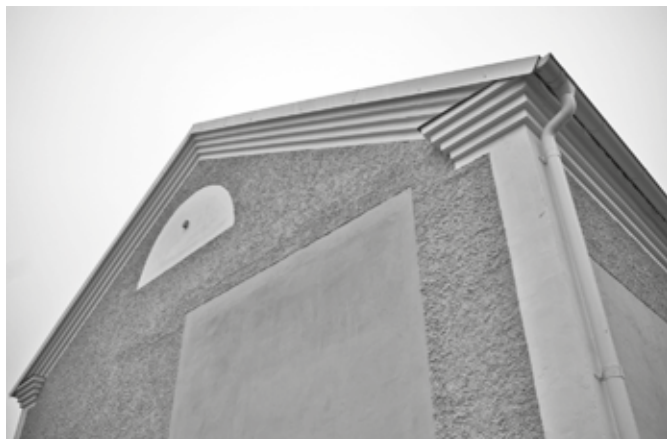
De vackra detaljerna i slakthusets fasad har kommit fram efter renoveringen.
