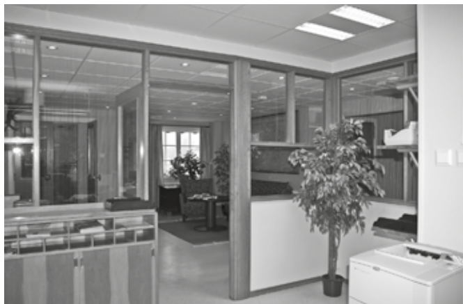
Färdigt! Nytt golv och tak, ny belysning, en borttagen vägg, ny färg på väggarna.
