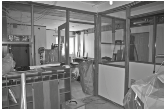
Så här såg vår foajé ut under renoveringen; sladdar, säckar, plast, verktyg...
