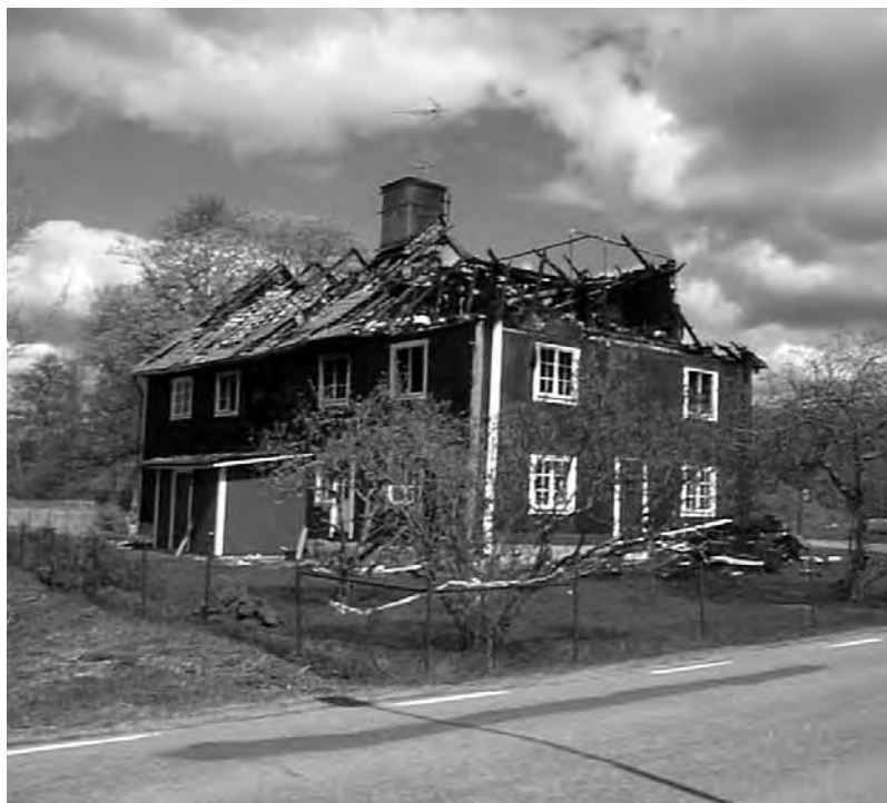
Nedre Bruket efter branden. Av det gamla trähusets överdel finns bara skalet kvar.
