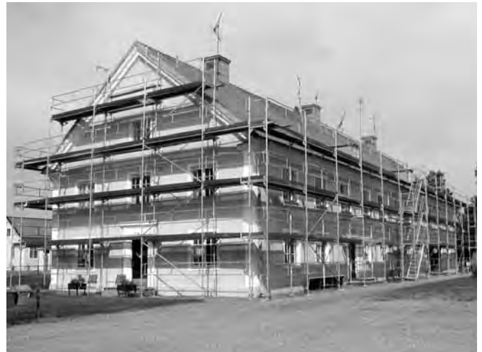
Fasadrenovering av Vårdshuset sommaren 2003.
