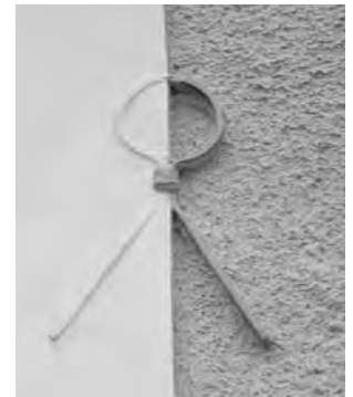
Detalj av ankarjärn för förankring av golvbjälkar
