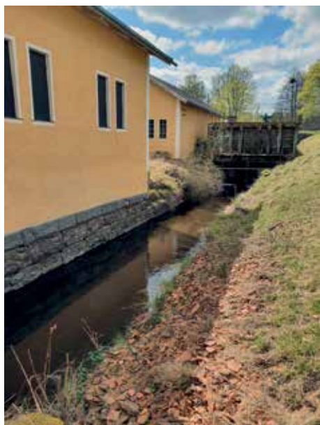
I den gamla kraftverkskanalen kommer endast ett litet flöde finnas kvar.
