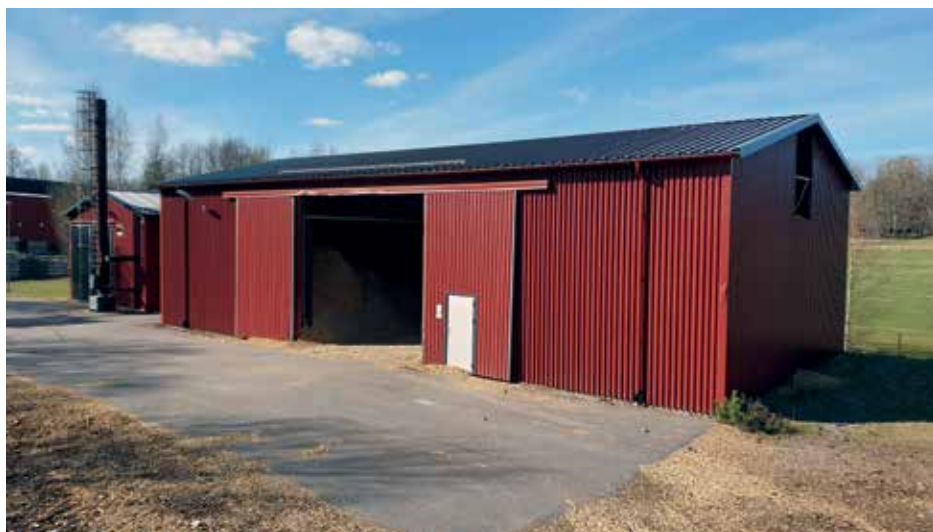
Här på flislagrets tak är det tänkt att solceller ska placeras.
