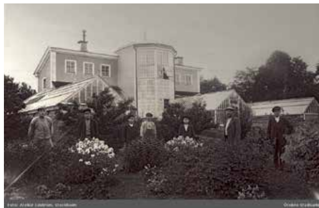
En grupp trädgårdsarbetare har samlats i trädgården nedanför orangeriet. Här kan man se att byggnaden är högre än på ritningen. Bilden är troligen tagen under 1920-talet.
